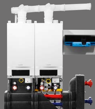
Крок 3: монтаж конденсаційних котлів, підключення насосних груп, автоматики керування та системи димовидалення
